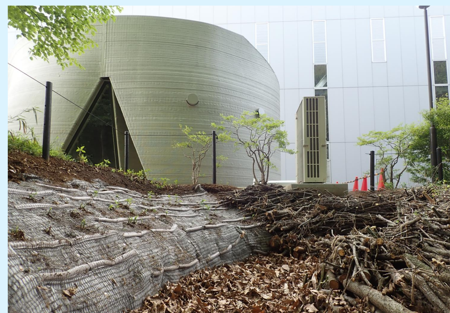
大林組技術研究所内に建設された3Dプリンタ実証棟 (3dpod™)の雨水処理施設として整備
