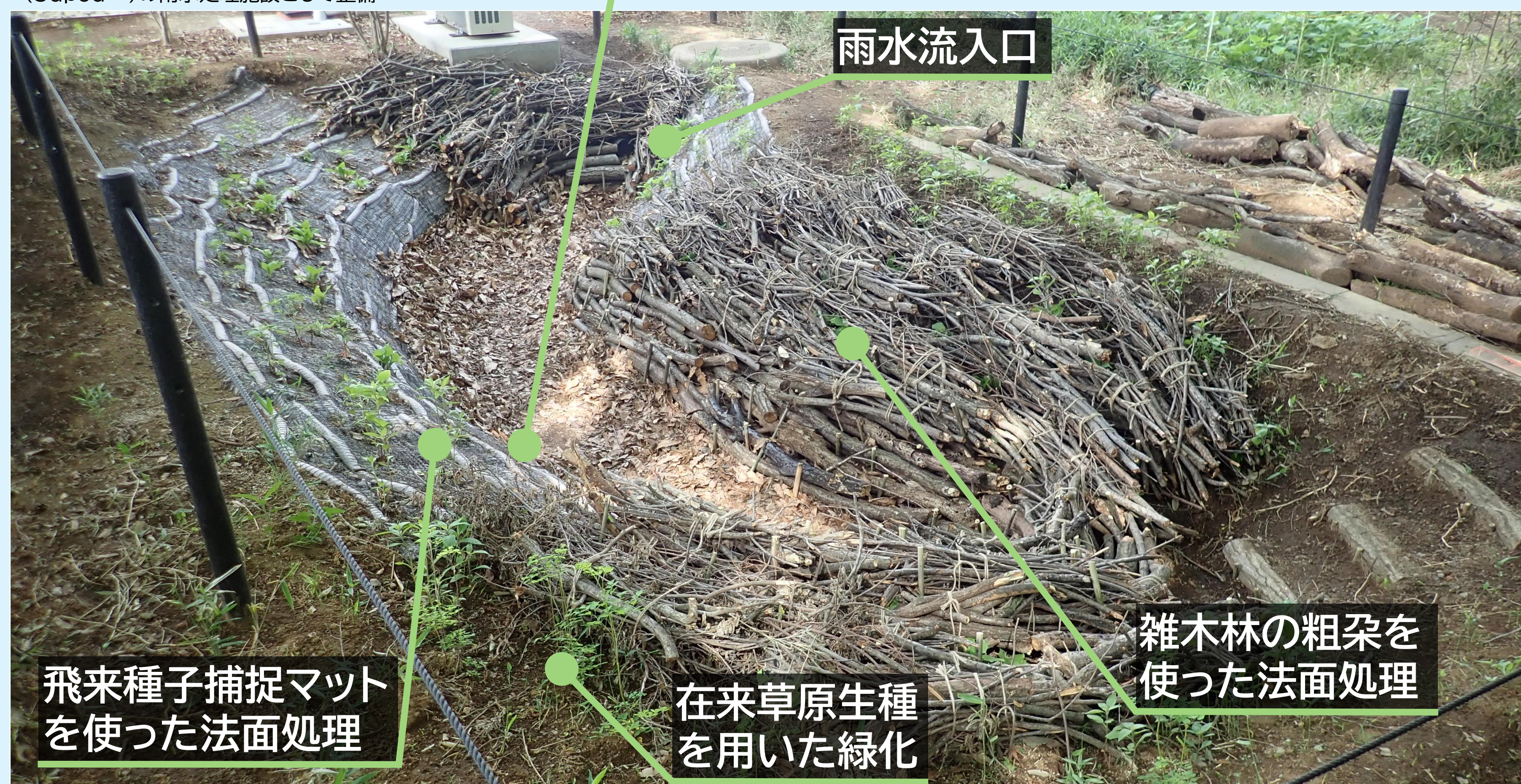
大林組技術研究所内に建設された3Dプリンタ実証棟 (3dpod™)の雨水処理施設として整備
