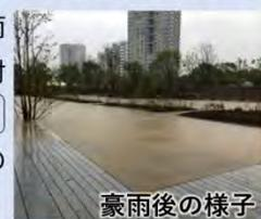
の植栽地浸透量、生態池調整容量を加えると総雨量の約66%（363mm<sup>3</sup>）の貯留浸透能を有することを確認
