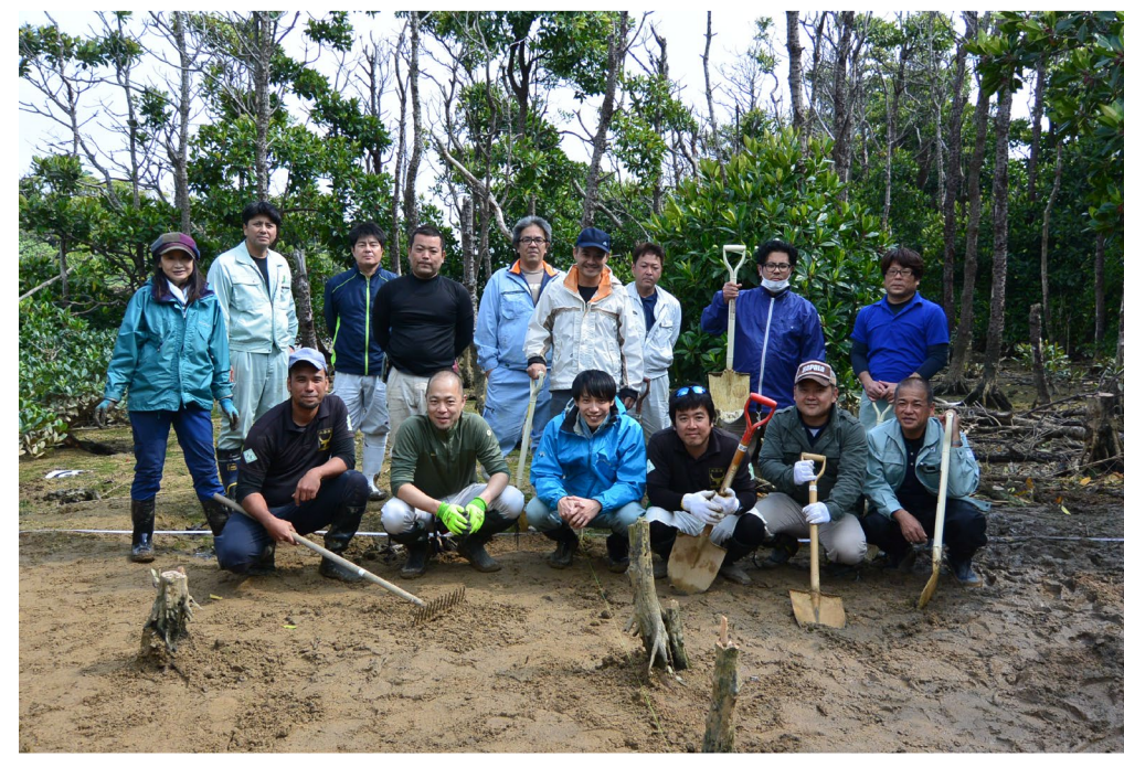
種子の着床を促進するための河床の試験掘削（2017/3）
