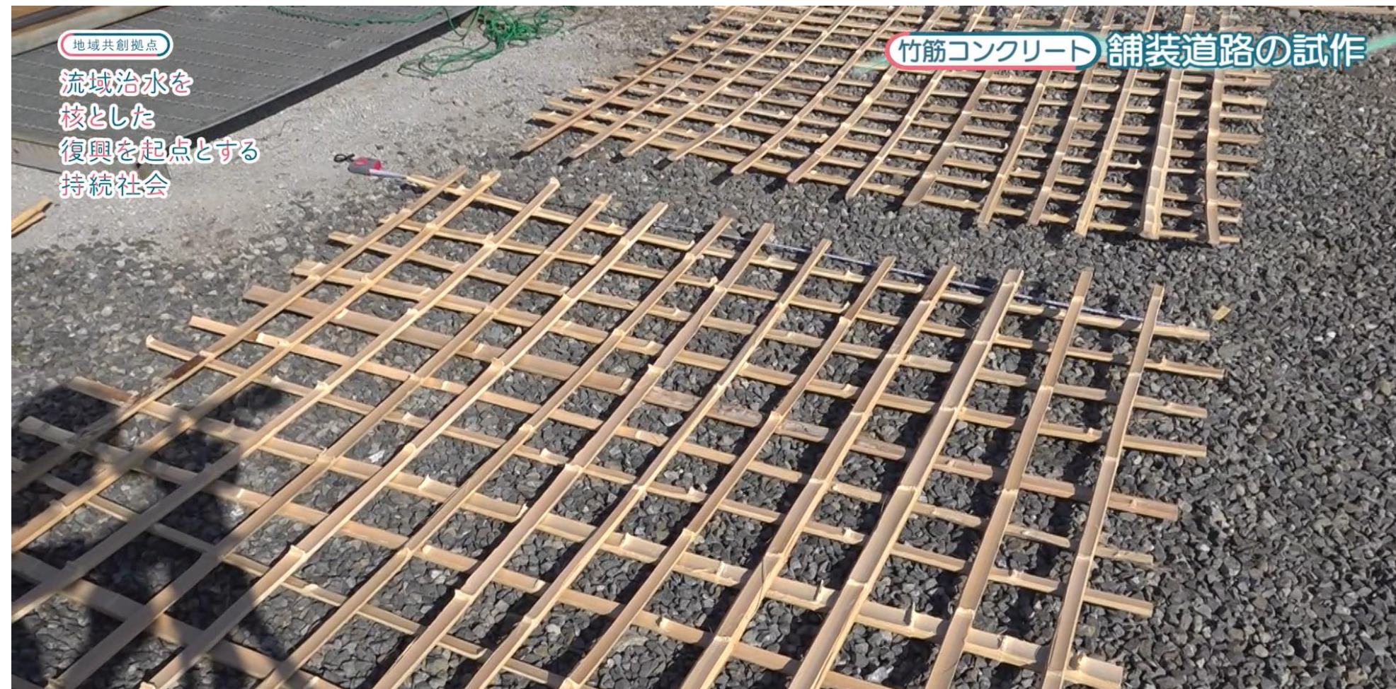
竹筋コンクリート施工の様子
