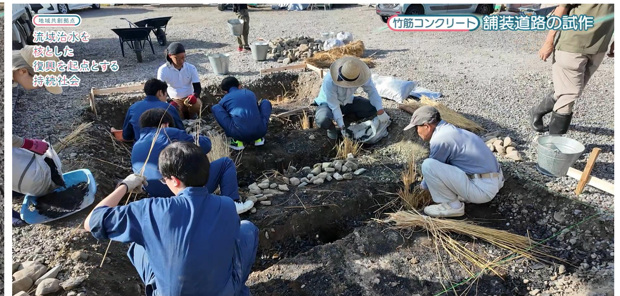
竹筋コンクリート施工の様子
