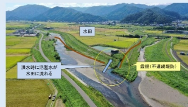
Fig.2 福井県・北川の霞堤とその機能
